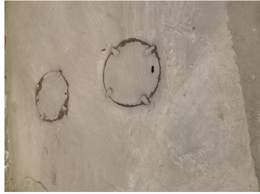
厂区内化粪池
