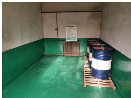
危废间内景（重点防渗）
