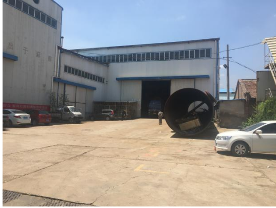
厂区生产车间（隔声）
